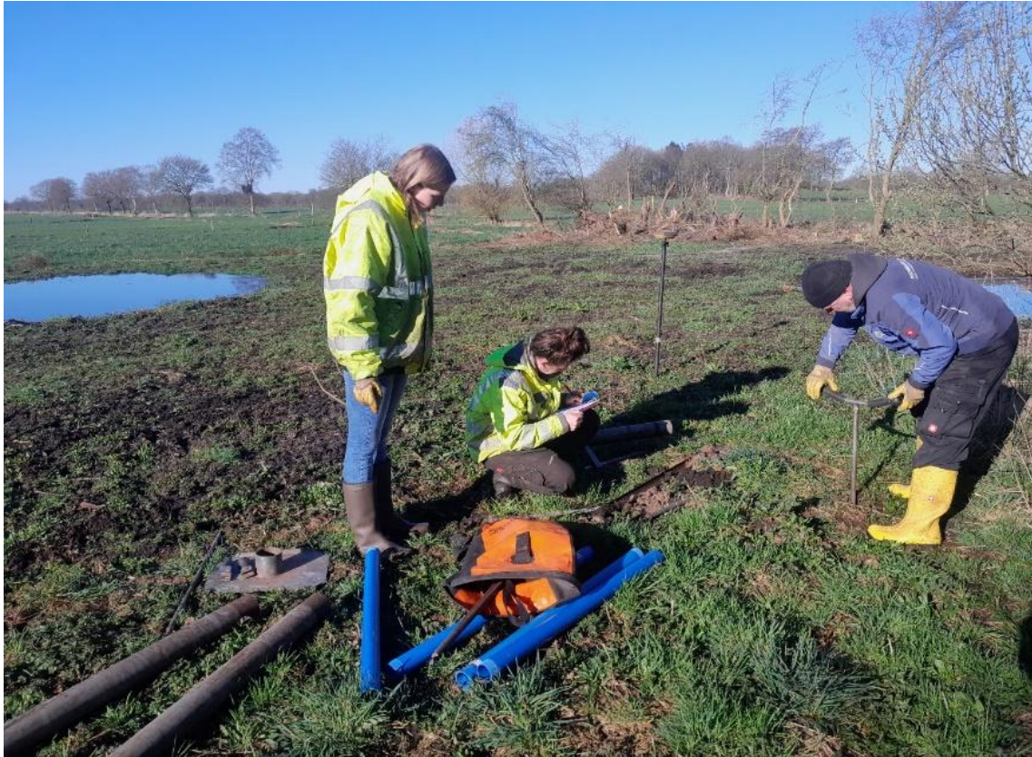
Bau von Messstellen im Rahmen des Projekts „Schaufenster Biodiversität“ auf den Projektflächen M1, M3 und M4 durch das Ingenieurbüro Linnemann. Foto: Thomas Linß.
