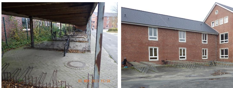
Abb. 65 Schulzentrum Esens: Abstellanlagen in Form von überdachten Vorderradklemmen und Anlehnbügeln
