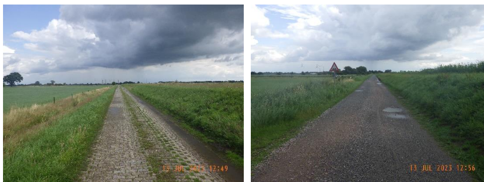
Abb. 51 Anglerweg; Wirtschaftsweg mit Sanierungsbedarf
