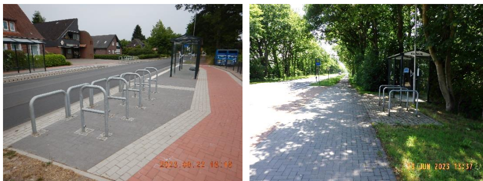
Abb. 63 Fahrradabstellanlagen an Bushaltestellen Burhufe, Ort (links); Dunum, Alter Postweg (rechts)
